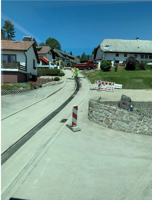
Nach den Verlegearbeiten wird der Grabenbereich wieder verschlossen, verdichtet und Asphalt eingebaut. Die Hausanschlüsse wurden aus dem Straßenkörper heraus ca. 1m in Ihr Grundstück gelegt und ggf. schon angeschlossen.
